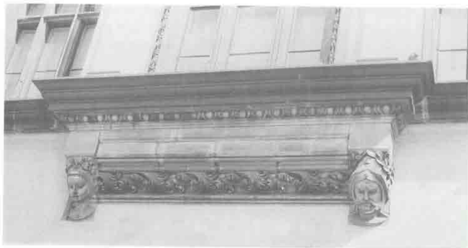
7. Konsola pod środkowym oknem ryzalitu zachodniego (fot. A. Broż)
